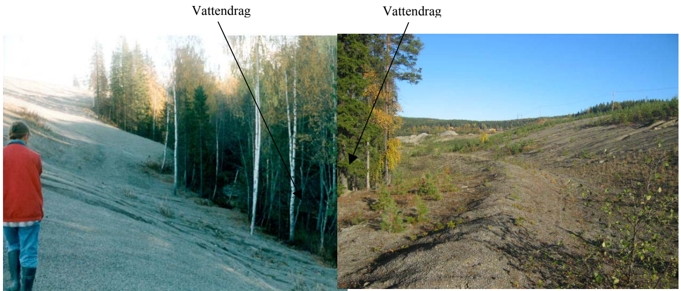
Grustäkt som sluttar mot Sulån. Stort materialläckage sker nedför slänten mot ån.
