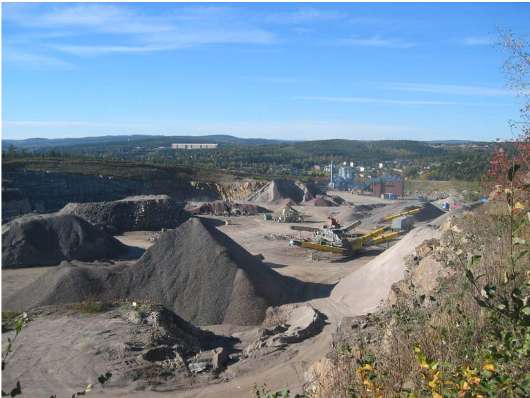
Bergtäkten Råsta. I bakgrunden syns, förutom Sundsvall sjukhus, även bergtäkten Färsta till höger i bilden.
