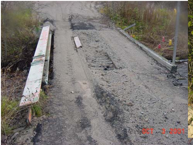
Exempel på dåligt skydd mot partikelflykt: öppna och låga sidobalkar, samt öppningar i mitten av bron.
