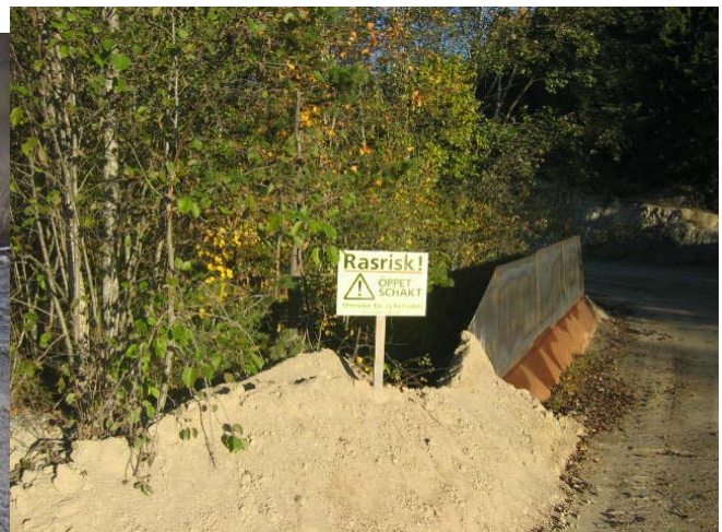
Bättre skydd mot läckage: höga sidoskydd och tät botten. Vallen i förgrunden är också tänkt som skydd men måste få vegetationstäckning som binder. Skylten avser täktområdet innanför.
