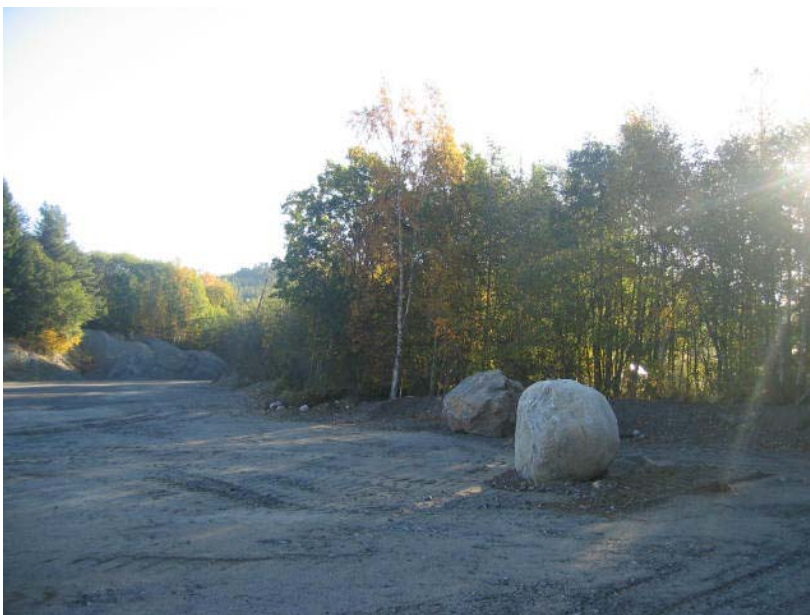
Täktbotten lutar från ån. Skyddet har förstärkts med en vall med kolonisationskärnor/fröbank för snabbare etablering av vegetation, samt block som avgränsar verksamhetsområdet.
